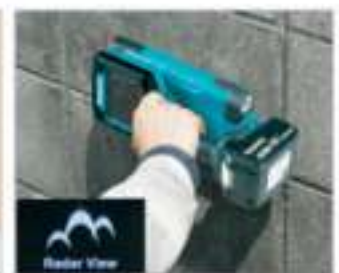
Betonski blok/zid od cigle
